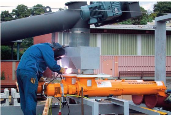
Bild 9: Installation der Misch und Förderanlage auf dem DB Waggon
