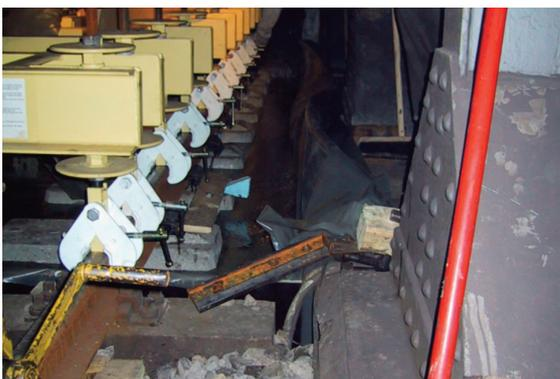
Bild 3: Eingehobenes Abschnitts-Gleiselement vor dem Verguss
