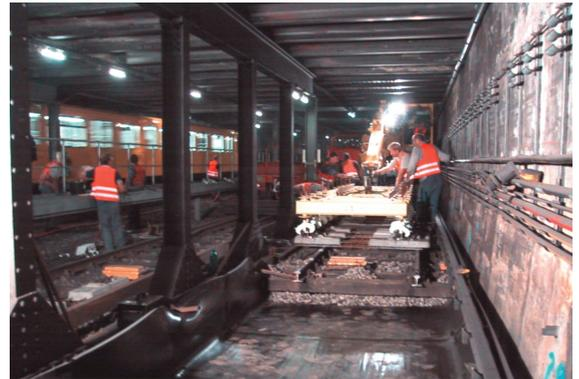
Bild 2: Eingleisige Sperrung während der nächtlichen Umbauarbeiten
