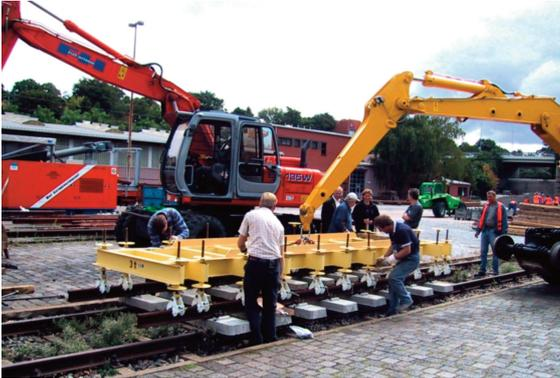
Bild 5: Maschinenkonstruktion zum Einsetzen des montierten Gleisabschnittes in der Testphase
