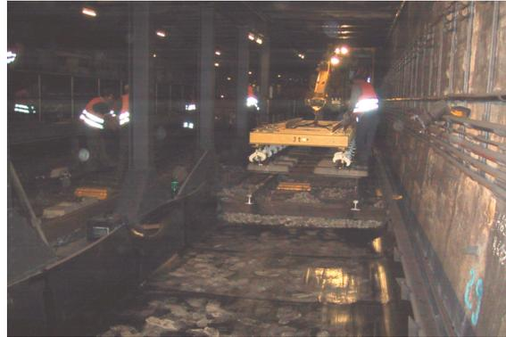
Bild 6: Maschinenkonstruktion zum Einsetzen des montierten Gleisabschnittes im Praxiseinsatz
