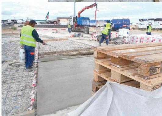
**Bild 2:** Breite 5 m (nachher geschnitten) - Bespritzung mit Wasser ca. 45 bis 60 Minuten
