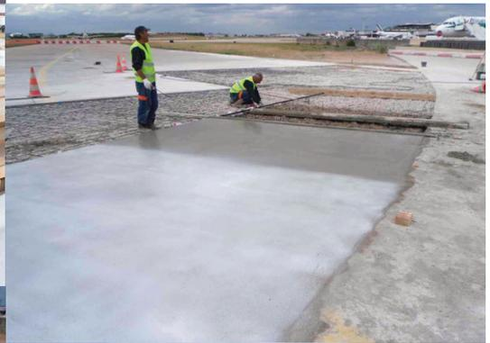
**Bild 5:** freie Fläche weiter mit Wasser bespritzt
