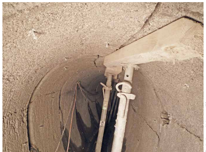
Bild 2 Vorhandene Risse in den Viertelpunkten und im Scheitelpunkt sowie temporäre Stützungen Existing cracks in quarter points and crown; temporary supporting is also seen
