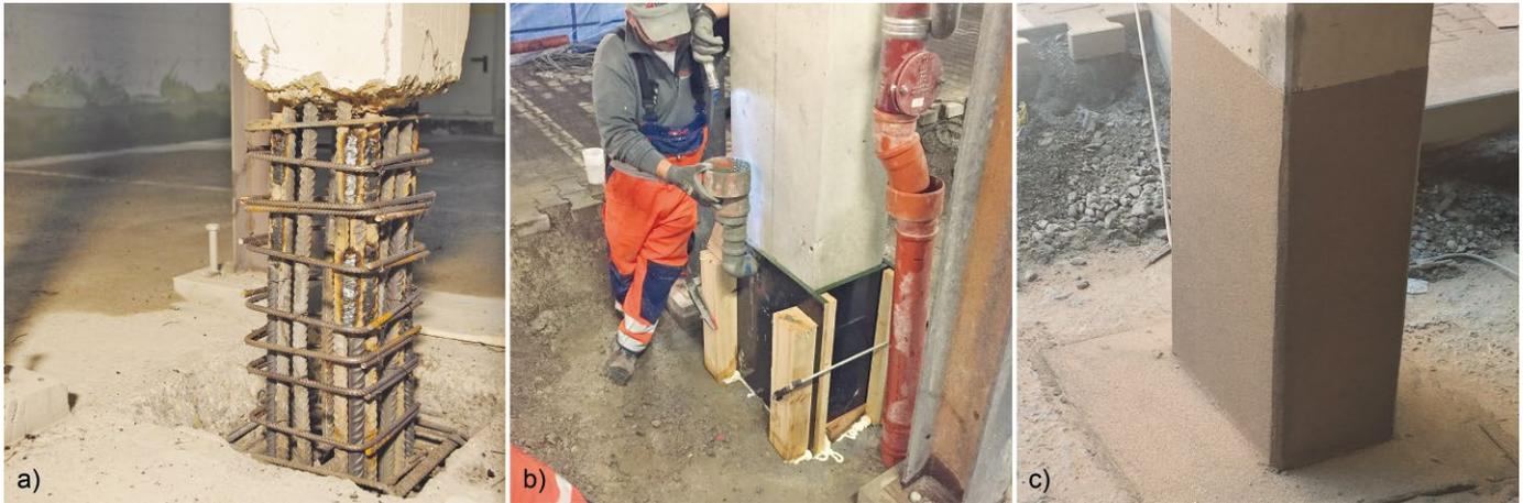
**Bild 5** Betoninstandsetzung eines Stützenfußes mit Vergussbeton: a) vorbereitete Stütze bei vollständigem Ersatz des Betons, b) Verguss über Einfüllöffnung, nichtsaugende Schalung, abgedichtet gegen Untergrund, c) reprofiliertes Stützenfuß nach dem Ausschalen
