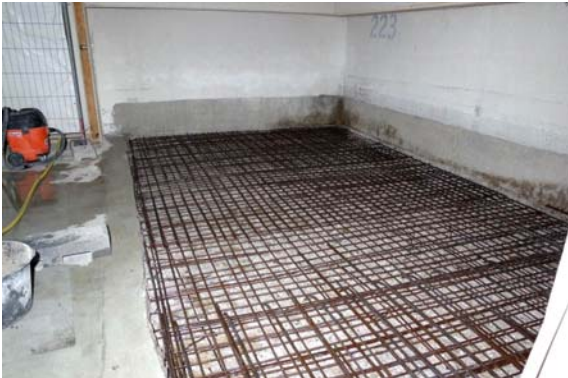
Abbildung 3: Freigelegte und zusätzlich bewehrte Fläche
