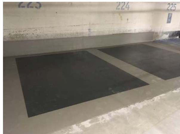
Abbildung 5: Instandgesetzte Fläche mit OS-System
