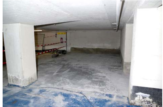
Abbildung 4: Instandgesetzte Fläche vor dem Kugelstrahlen
