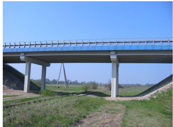
Widok wyremontowanego wiaduktu w ciągu DK 3 w miejscowości Prochowice
