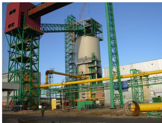
Koksownia Przyjaźń – remont wieży węglowej
