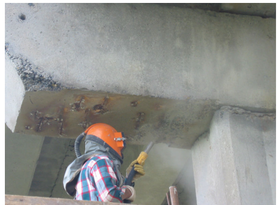
Oczyszczenie podłoża betonowego metodą piaskowania
