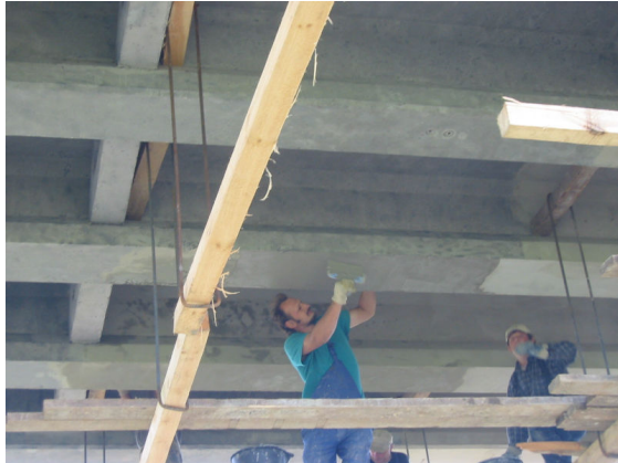
Aplikacja zapraw naprawczych PAGEL
