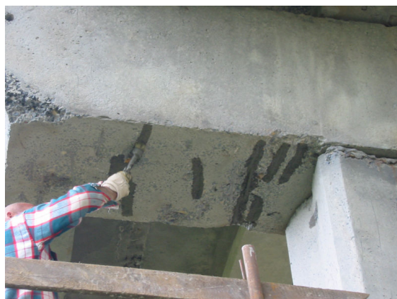
Antykorozyjne zabezpieczenie oczyszczonej stali zbrojeniowej
