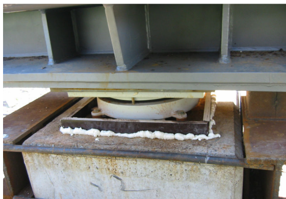
Widok zaszalowanego, ustawionego łożyska, wraz z zabezpieczeniem szalunku przed „ucieczką zaprawy”
