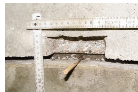
Undichte Schachtfugen
