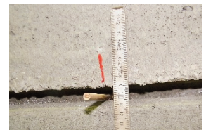
Undichte Ringfugen
