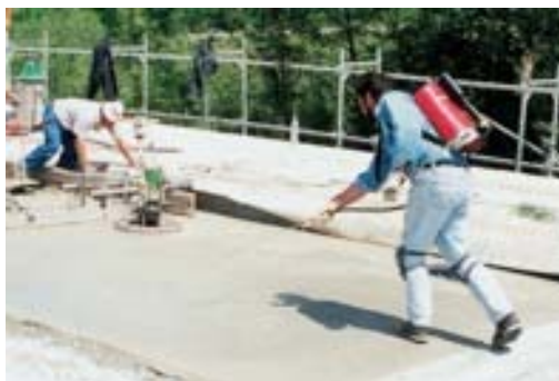
Zabezpieczenie naprawionej powierzchni przed odparowaniem wody
