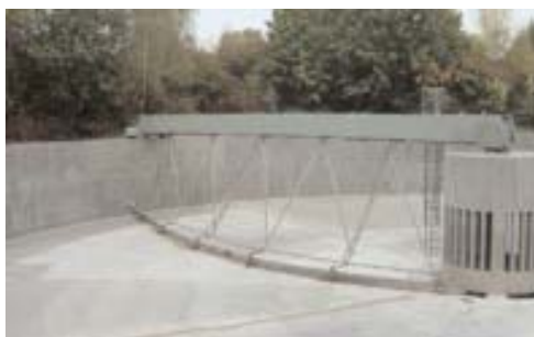
Widok naprawionego zbiornika wody pitnej i osadnika wtórnego w oczyszczalni ścieków
