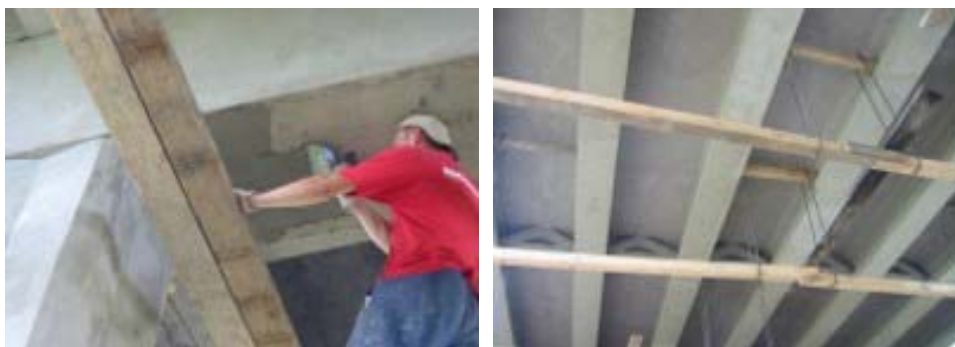
Uzupełnianie ubytków betonu i widok zaspachlowanych dźwigarów
