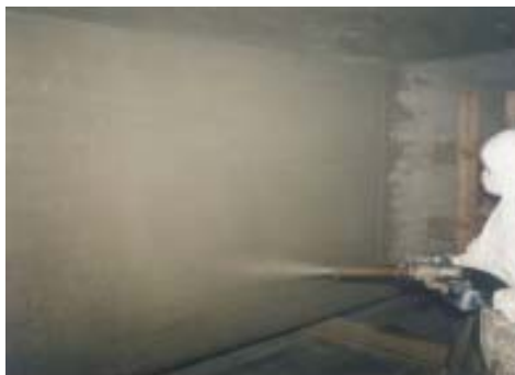
Naprawa płyty pomostowej zaprawą PCC Wykonywanie natrysku zaprawą SPCC
