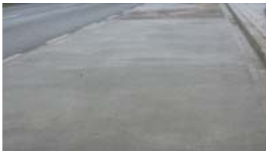
Naprawiona powierzchnia zatoki autobusowej zaprawą szybkowiązącą
