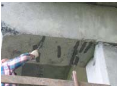
Usuwanie korozji ze zbrojenia oraz zabezpieczanie antykorozyjne oczyszczonej stali zbrojeniowej
