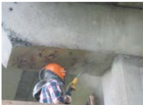
Czyszczenie powierzchni betonowej metodą piaskowania
