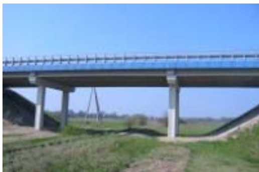
Widok zabezpieczonej powierzchni betonowej farbą
