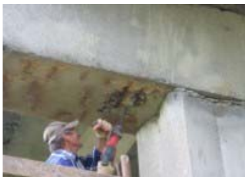
Usuwanie korozji ze zbrojenia oraz zabezpieczanie antykorozyjne oczyszczonej stali zbrojeniowej
