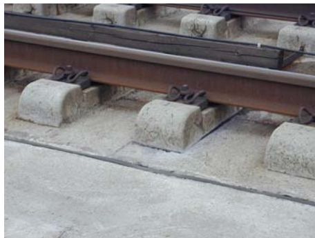
Abb. 1: Gelockerte Schwelle auf der SFS Hannover - Berlin
