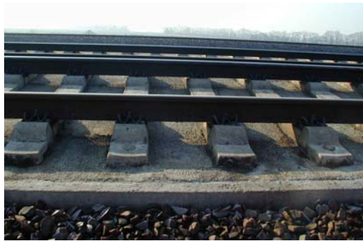
Abb. 13 : Ansicht des Einbauortes im Netzbezirk Wustermark vor dem Einbau
