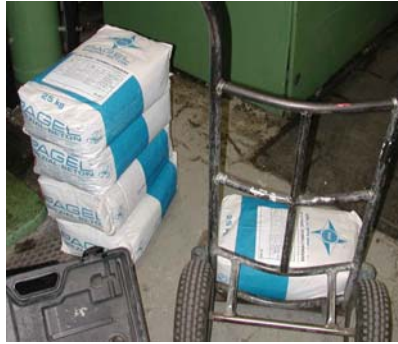
Abb. 7 u. 8: Hochleistungsmörtel V2/40 (Fa. Pagel) Gebinde bei Anlieferung und Anrühren mit Wasser
