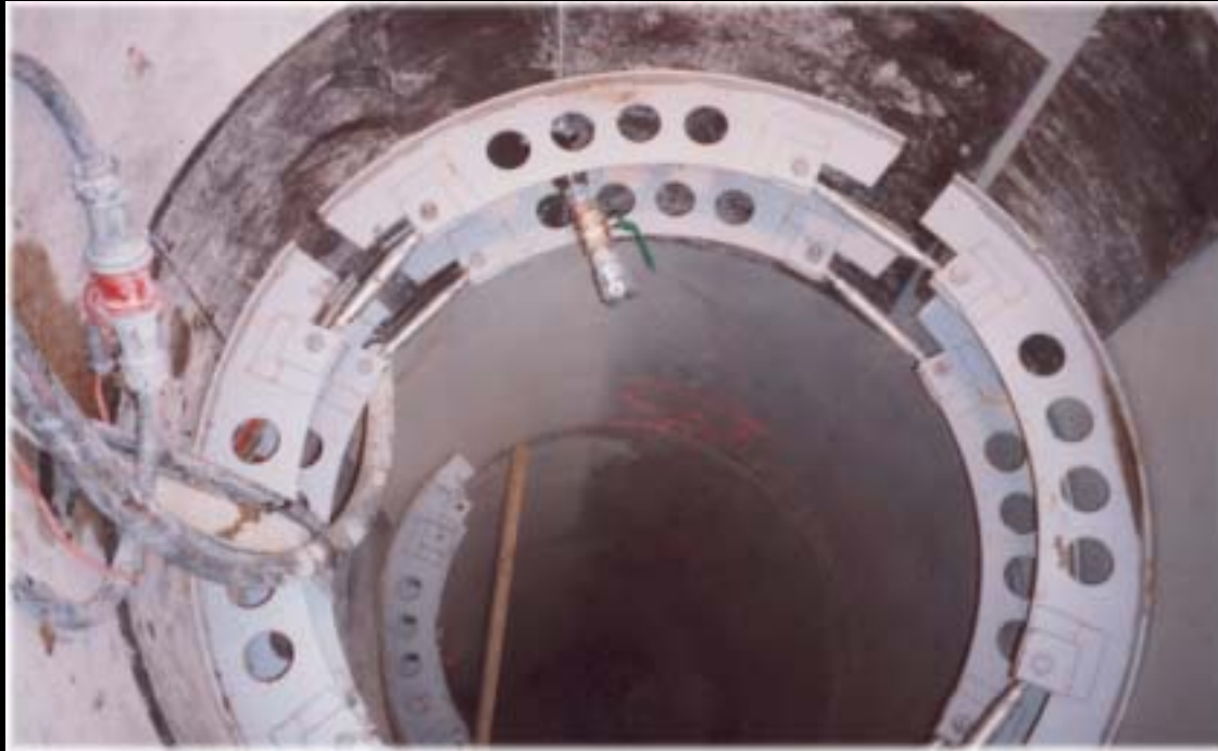
Übergangsbereiche der Muffen der Vortriebsrohre
