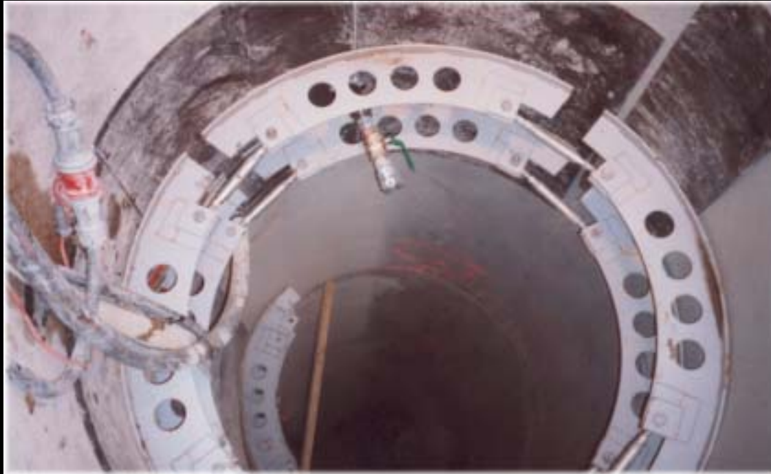
Übergangsbereiche der Muffen der Vortriebsrohre
